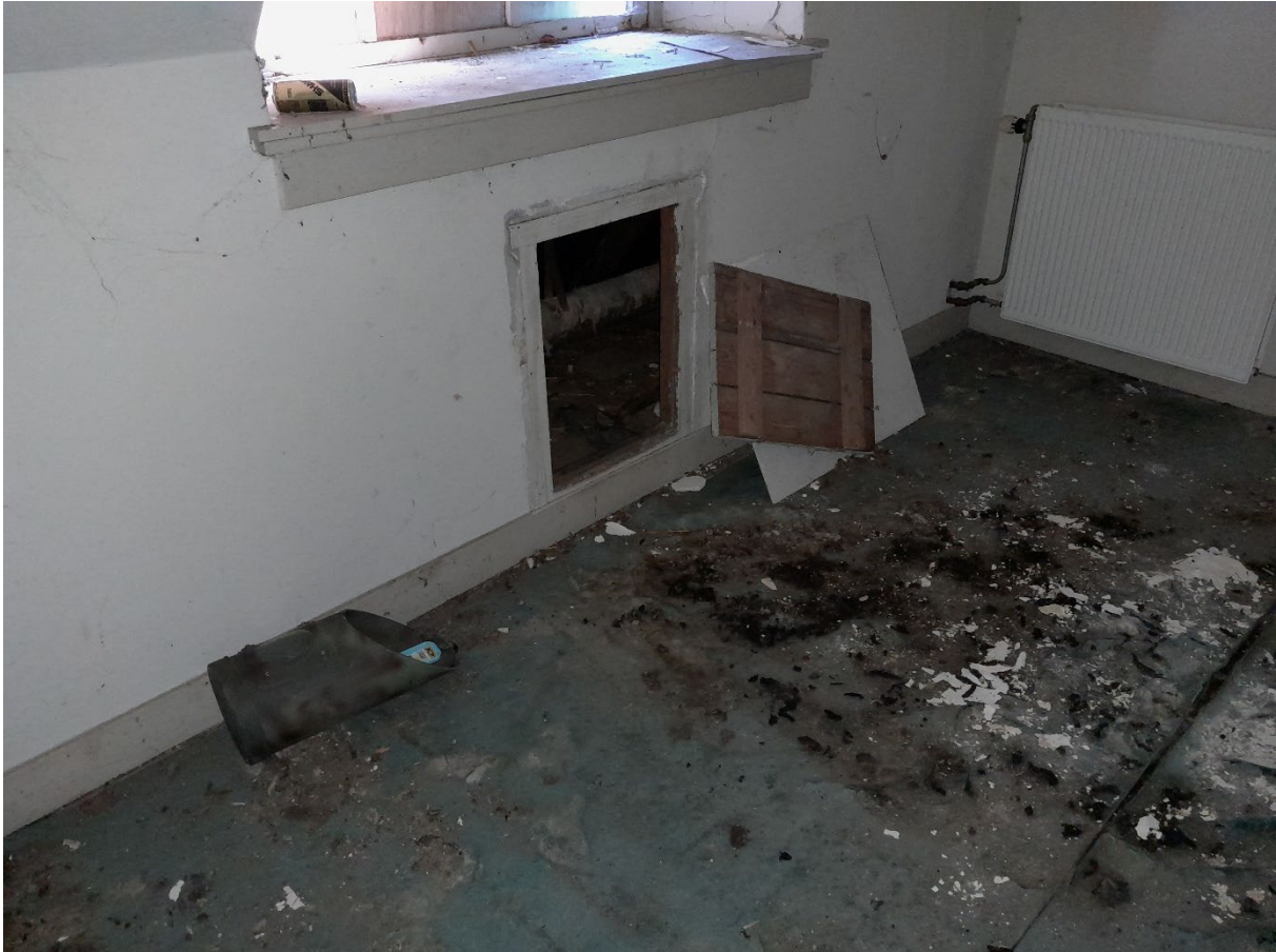
Afbeelding 18: Latrine op zolder met cameraval in struikrover.
