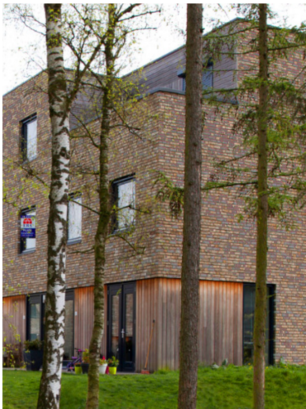
Genuanceerd metselwerk in beige-bruin Houtvlakken en details in de gevel, vergrijzend hout
