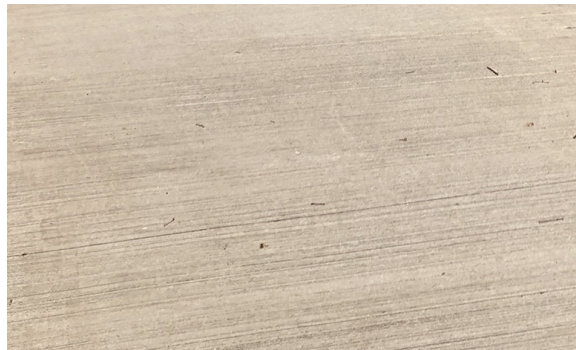
Hoofdstructuur, ter plaatse gestort beton met gebezemde afwerking
