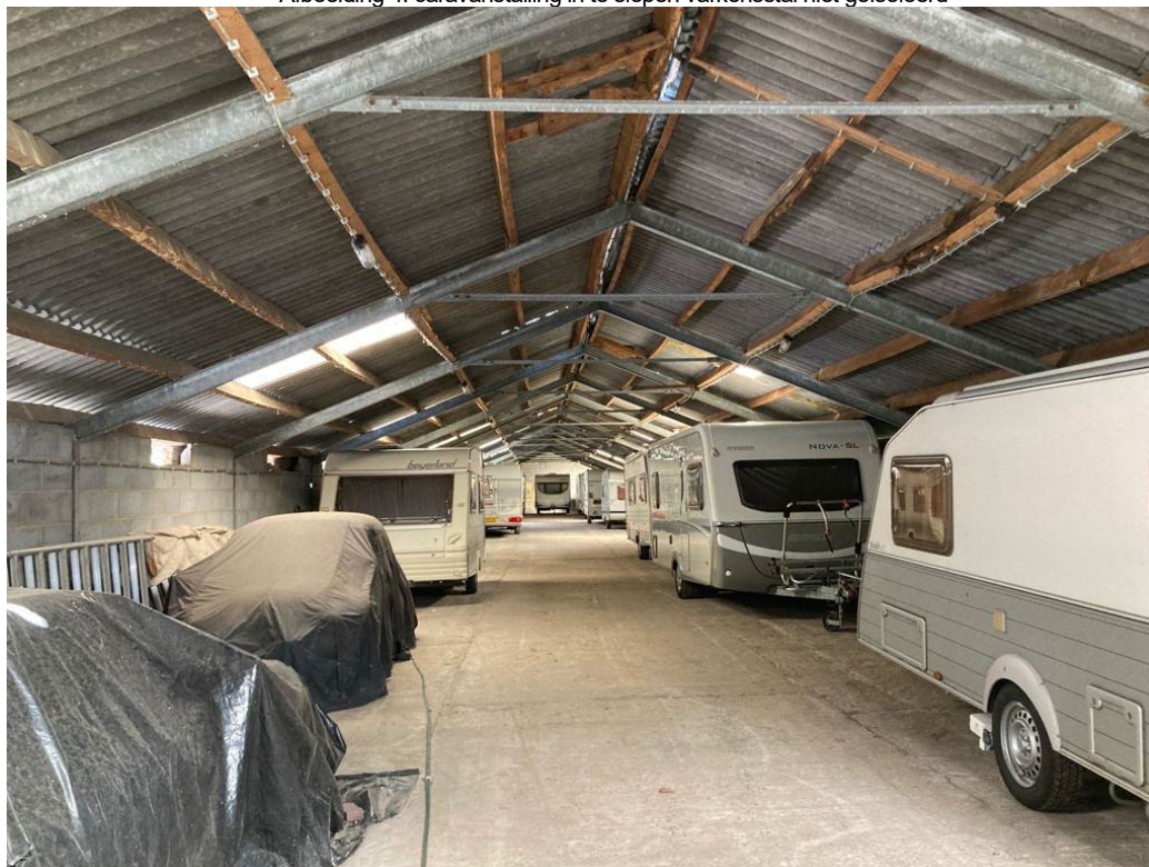
• Afbeelding 4: caravanstalling in te slopen varkensstal niet geïsoleerd
