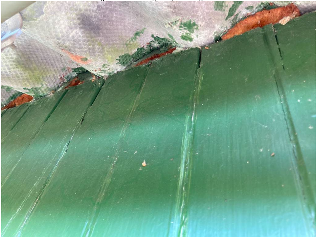
• Afbeelding 16: dak aansluiting te slopen woning
