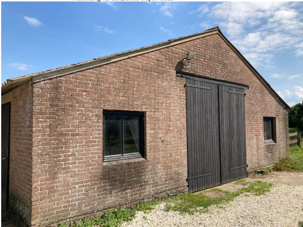
• Afbeelding 19: aanzicht te slopen loods
