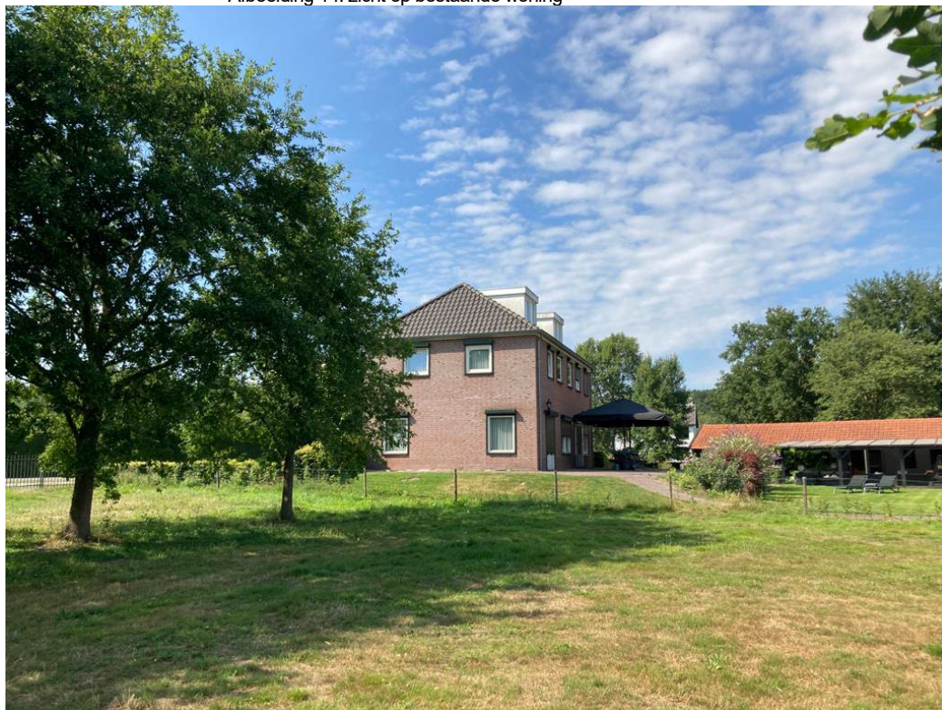
• Afbeelding 14: zicht op bestaande woning
