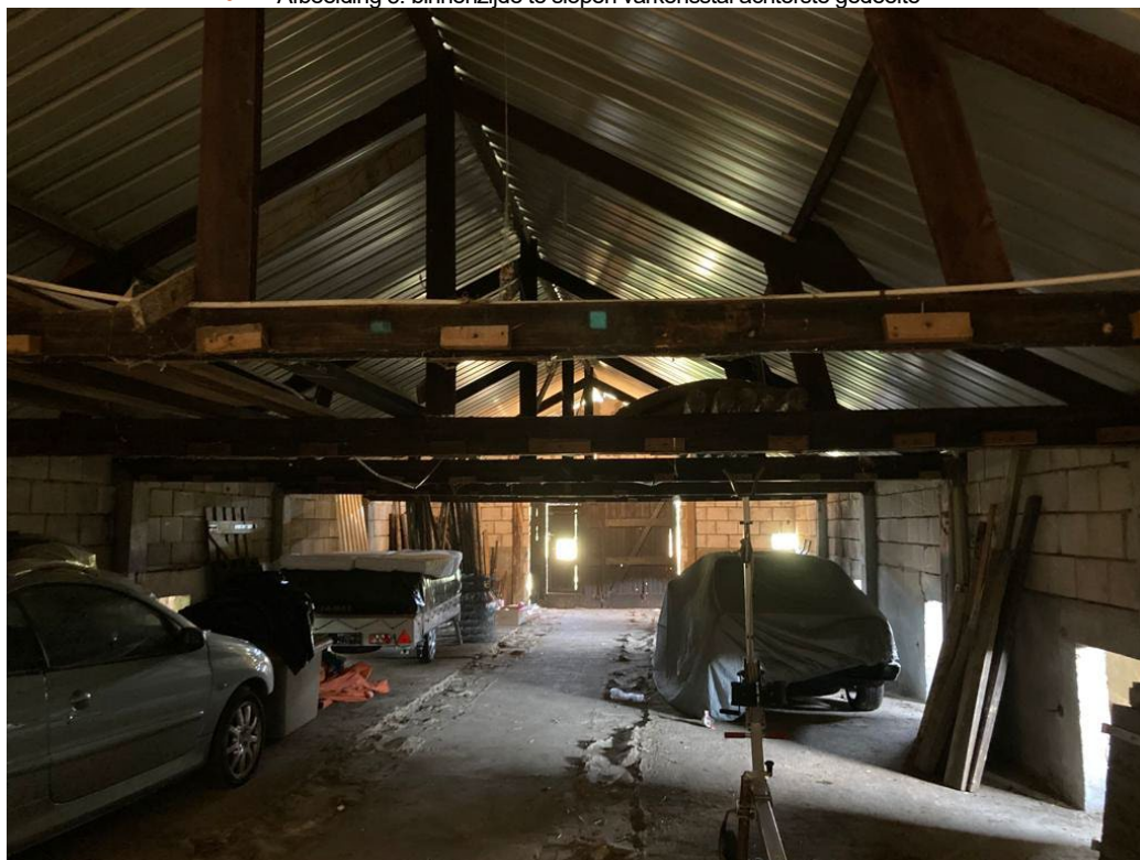
• Afbeelding 5: binnenzijde te slopen varkensstal achterste gedeelte
