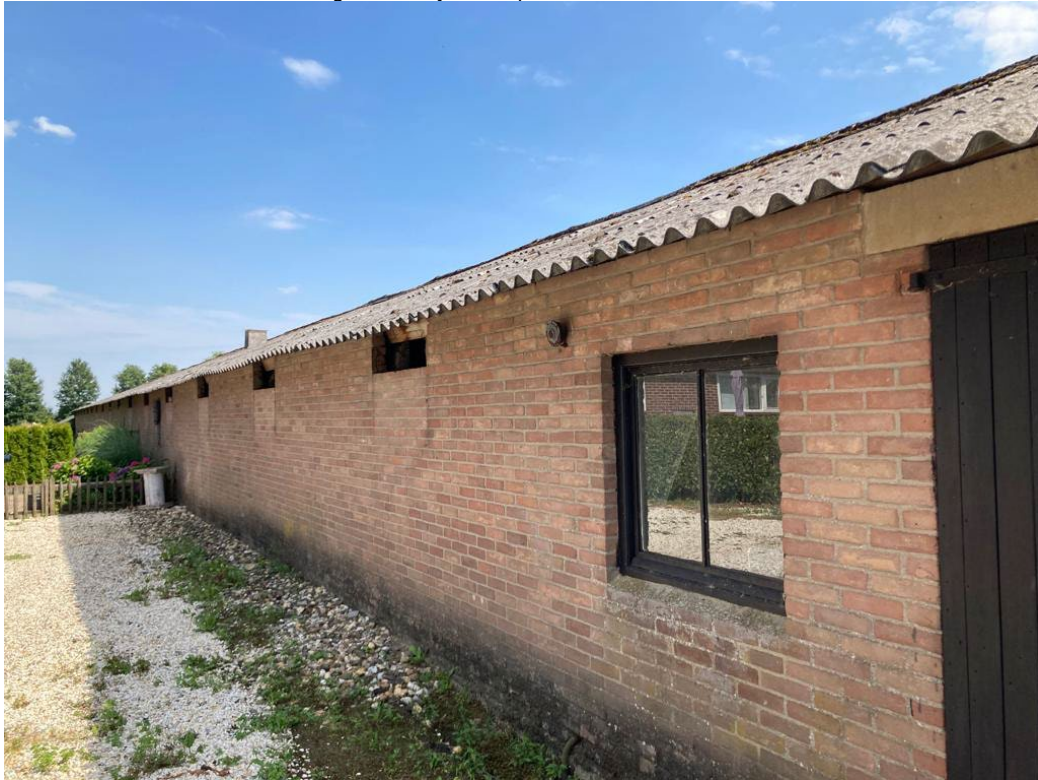
• Afbeelding 3: buitenzijde te slopen stallen
