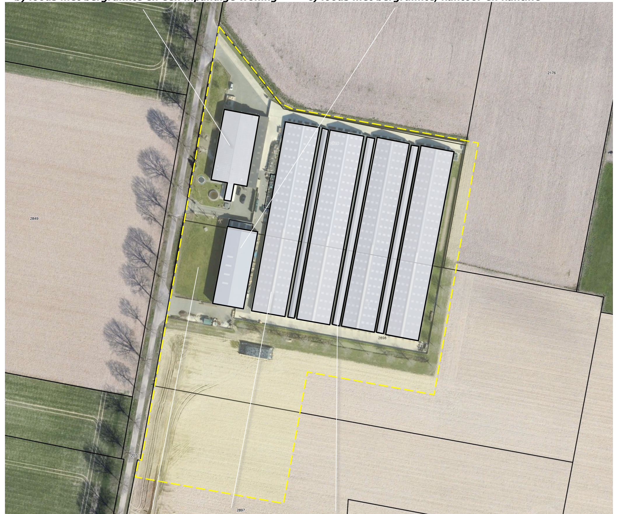
a) de voormalige nertsenstallen met tussenliggende afdaken
