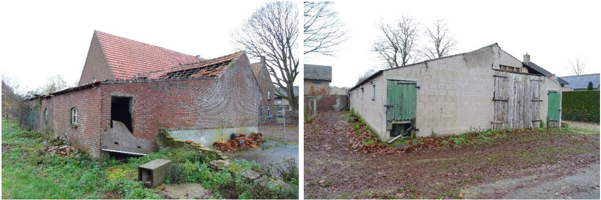
Afbeelding 5 en 6: de bestaande te slopen bijgebouwen. Bron: BNL Advies, datum: 26-11-2021
