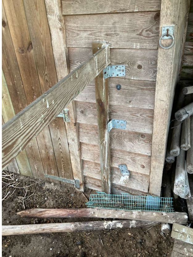
• Afbeelding 14: schapenstal met sporen van (steen)uil
