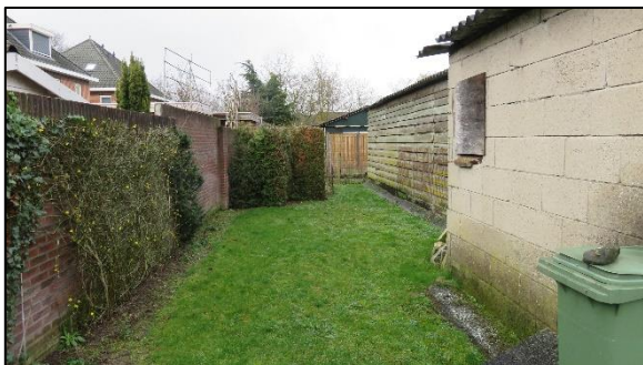
Foto 3. Westzijde van de schuur
