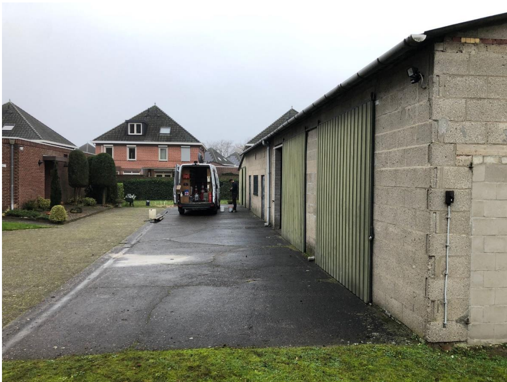
Verharding met goot voor loods
