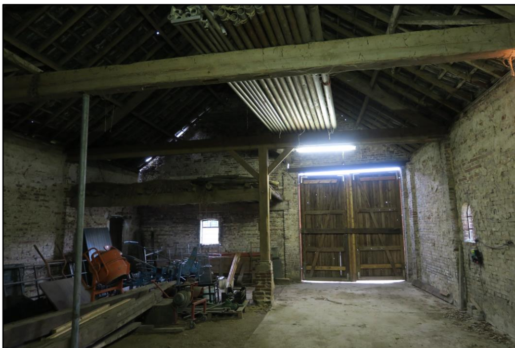
Figuur 2 De binnenkant van de schuur.
