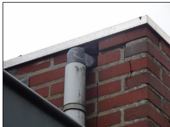
Figuur 112. Ruimte onder daklijst en bij regenpijp.
