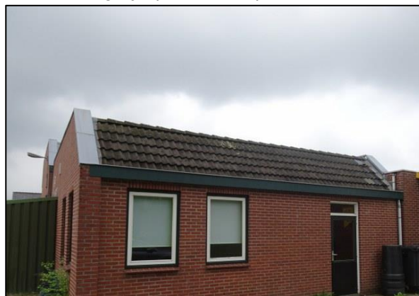
Figuur 10. Mogelijk ruimte onder nokpannen en onder dakgoot
