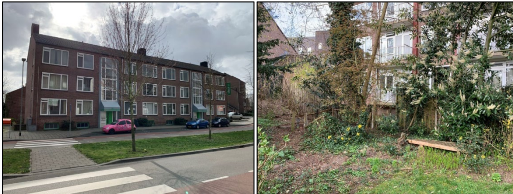
De voorgevel van het jaren '60 appartementencomplex met twee portiekentrees (links). In de tuin van de aangrenzende rijwoning aan de Zuidoosterlaan 5 staan (grote) bomen en het maai-veld loopt op richting de achterkant van de tuin, dat ca. 1.20 meter hoger ligt (rechts) (Bron: SAB).
