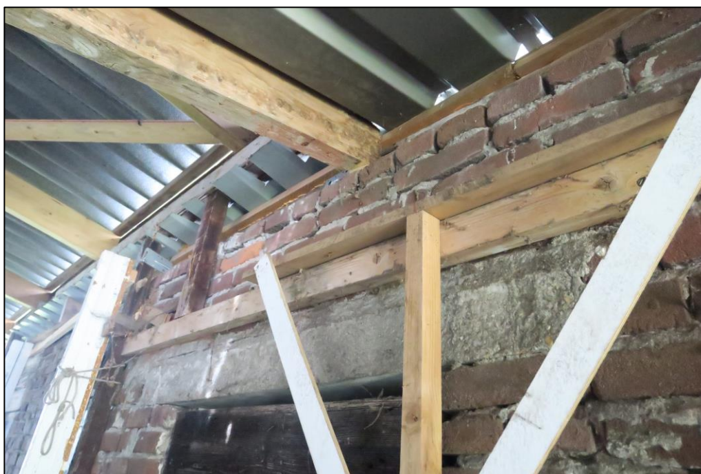
Figuur 4 De binnenzijde van de schuur.
