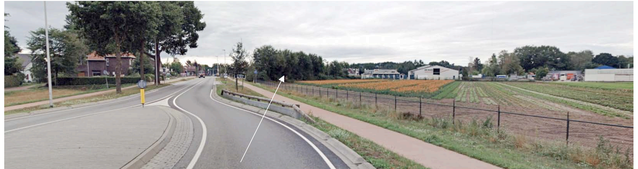
1) zicht op de westkant; beplanting definieert de rand naar het akkerland
