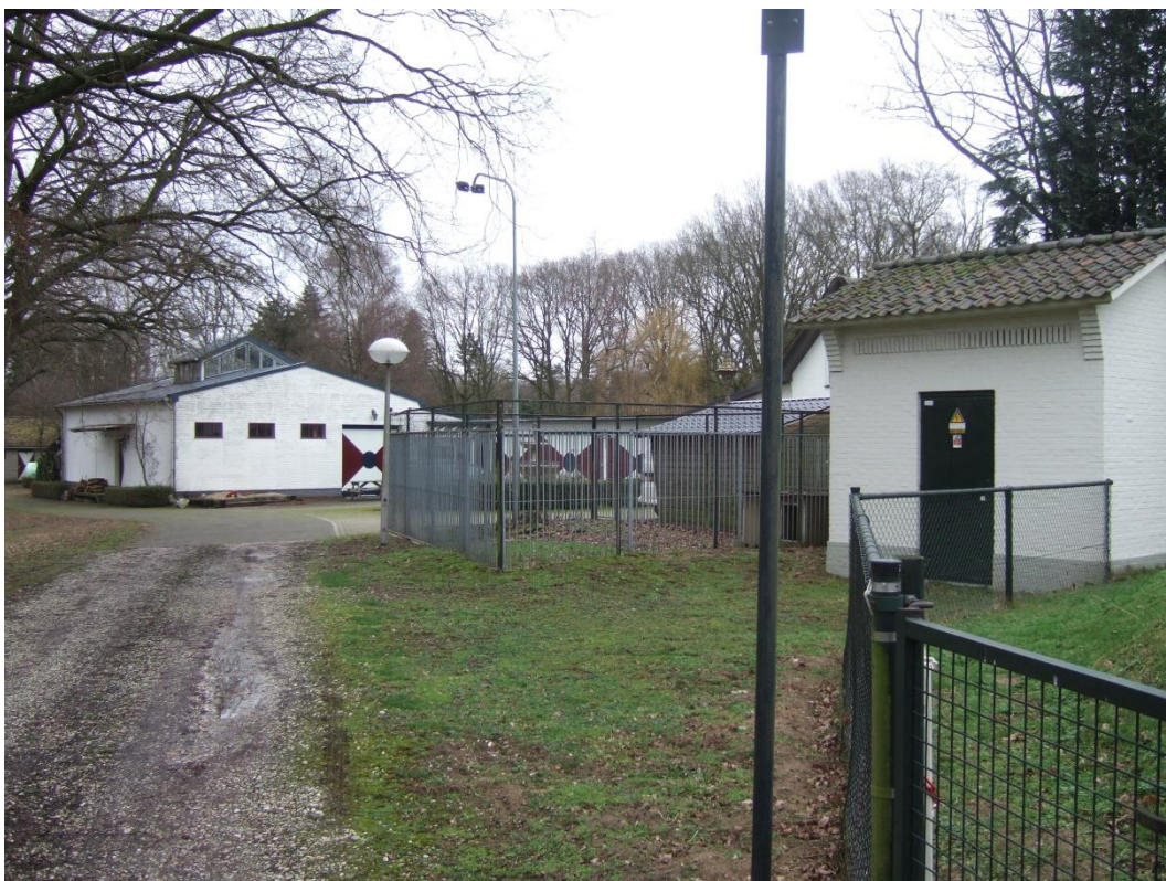
De toegang tot het terrein met aan de rechterzijde het transformatorhuisje en links op de afbeelding is de maalderij zichtbaar.
