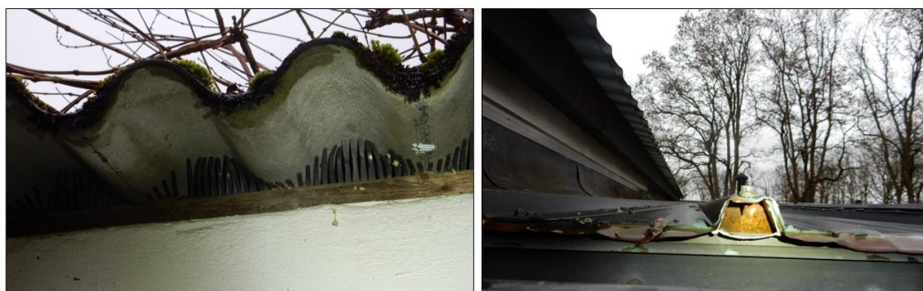
Figuur 4 Visuele representatie van het dak van de aanbouw (links) en het bijgebouw (rechts). De ruimten onder het dak zijn opgevuld met vogelwerend materiaal of isolatiemateriaal.
