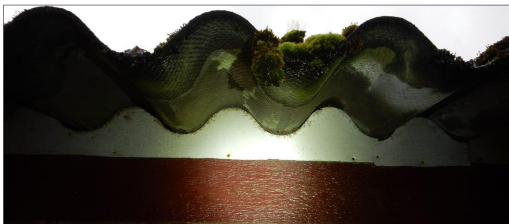
Figuur 5 Visuele representatie van het dak van mestkuikenschuur 1. De toegang tot de ruimte onder het golfplaten dak is afgedicht.
