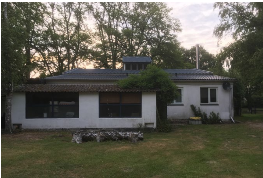
Voormalige maalderij met daarvoor het voormalige kippenhok
