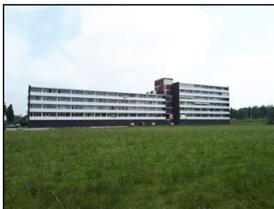
Figuur 3. Flatgebouw op de onderzoekslocatie.
