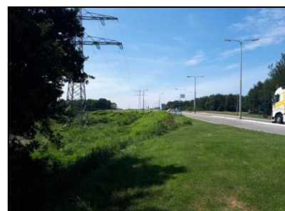
Figuur 7. Weg aan de zuidkant van de onderzoekslocatie.
