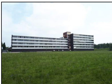
Figuur 2. Flatgebouw op de onderzoekslocatie.
