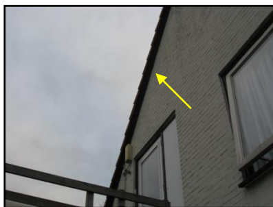
Figuur 13. Geschikte toegangsmogelijkheden langs de dakrand.
