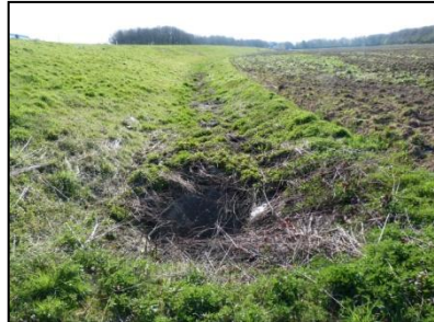
Figuur 5. Talud A77 aan zuidzijde van de onderzoekslocatie.
