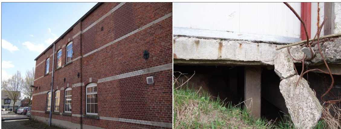
Afbeelding 5: Links de voormalige brandweerkazerne, rechts de blootliggende fundering onder de bebouwing van GEBRA (foto's: Kragten).
