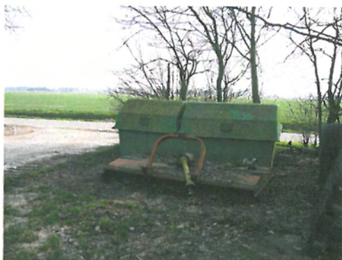
Foto D5 (Bovengrondse tank 1.200 l diesel in lekbak)
