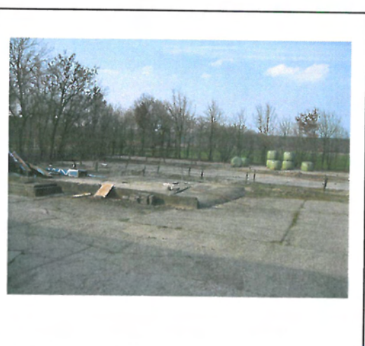
Foto E6 (betonvloeren van tbv kuilvoer en septictank)
