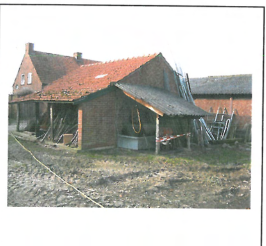
Foto E3 (bovengrondse tank in lekbak)
