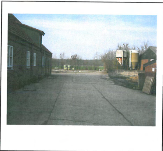
Foto E1 (betonverhard erf aan achterzijde woning)
