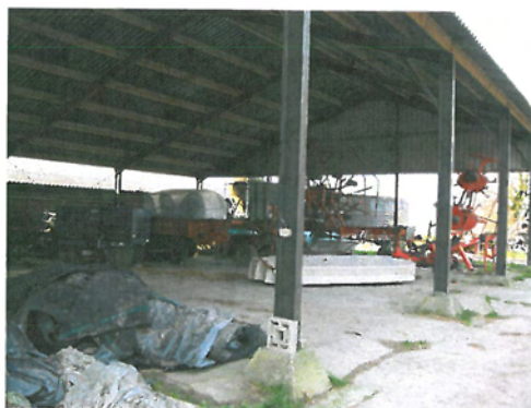
Foto D6 (veldschuur met betonvloer)
