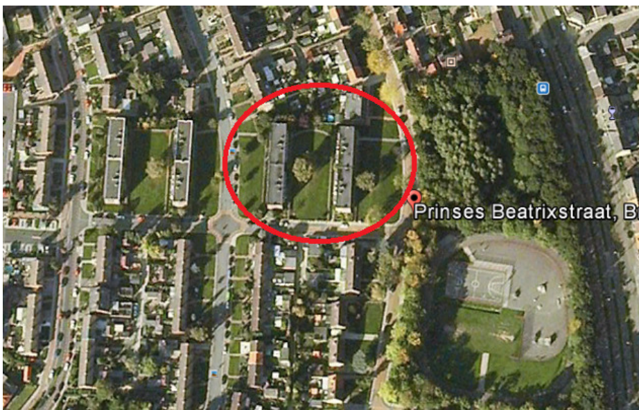
Luchtfoto uit 2005 (bron Google Earth).
