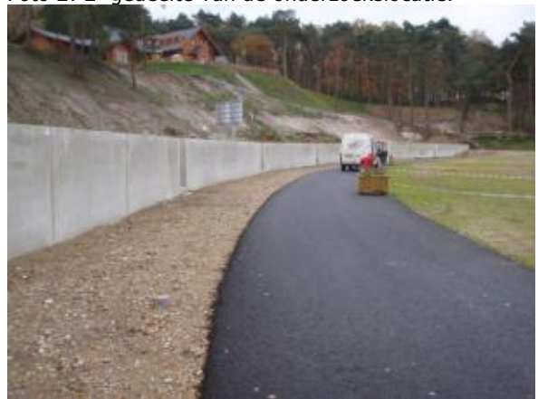
Foto 4: korrelmixverharding met daarnaast asfaltpad.
