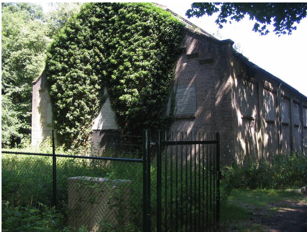
Foto 1: voorzijde pompgebouw met klimopbegroeiing
