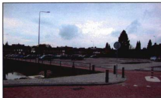
Het nieuwe parkeerterrein, gelegen ten westen van de projectlocatie
