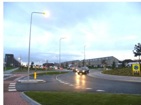
Westelijke entree Emma I: rotonde Pijler/Emmaweg
