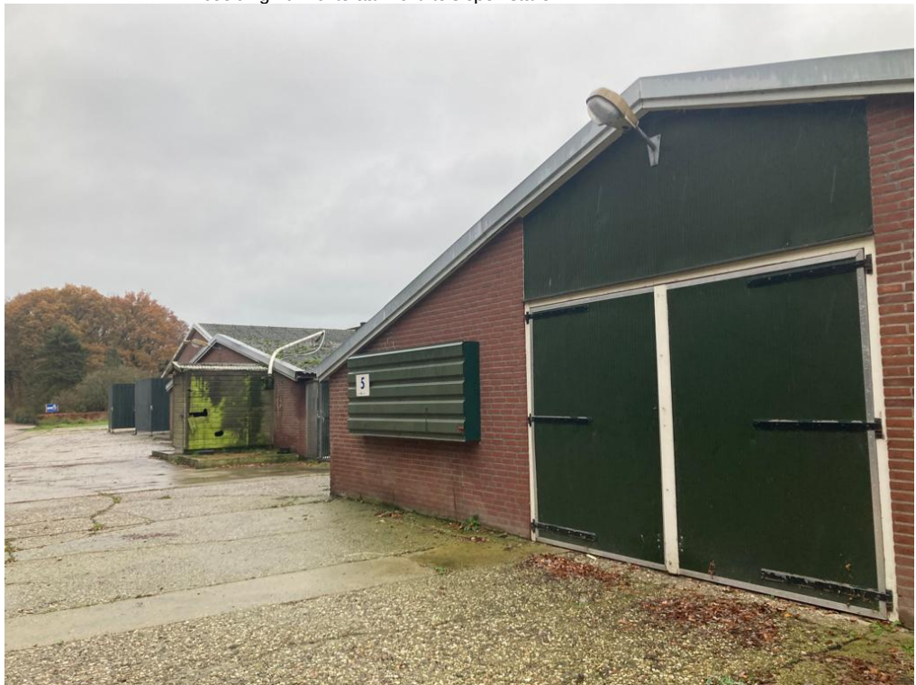
• Afbeelding 20: Achteraanzicht te slopen stallen
