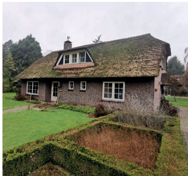
Beeld 2. Bestaande situatie bedrijfswoning
