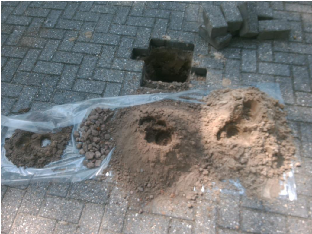
Asbestinspectiegat A03.
