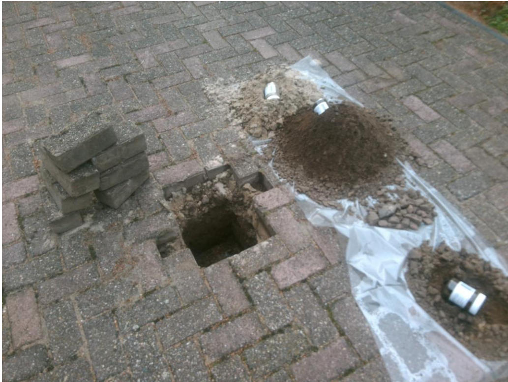
Asbestinspectiegat A05.
