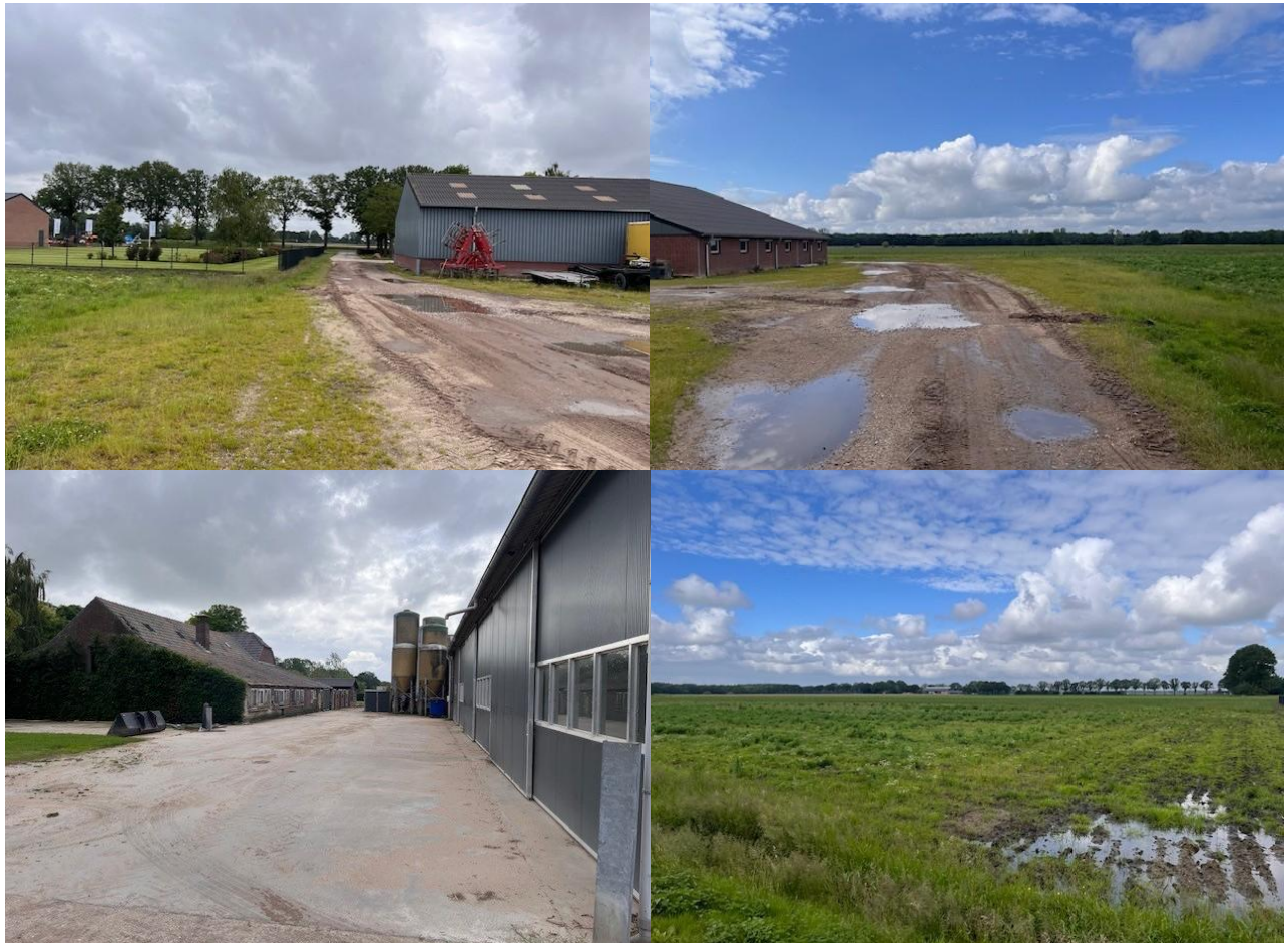
5: Huidige situatie plangebied, onderste foto rechts locatie nieuwe loods en mestsilo
