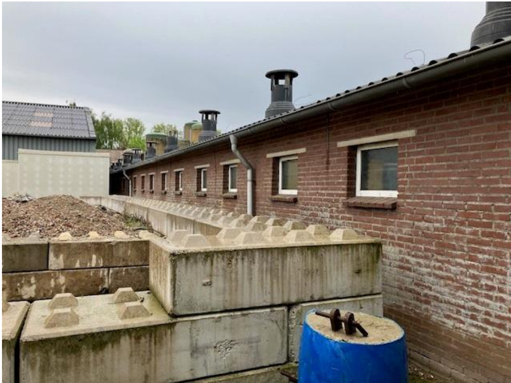
• Afbeelding 17: Te slopen stal
