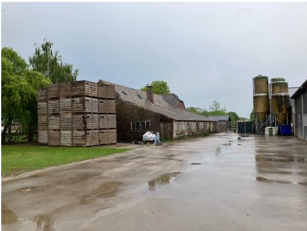
• Afbeelding 14: Uitzicht op het te slopen gedeelte
