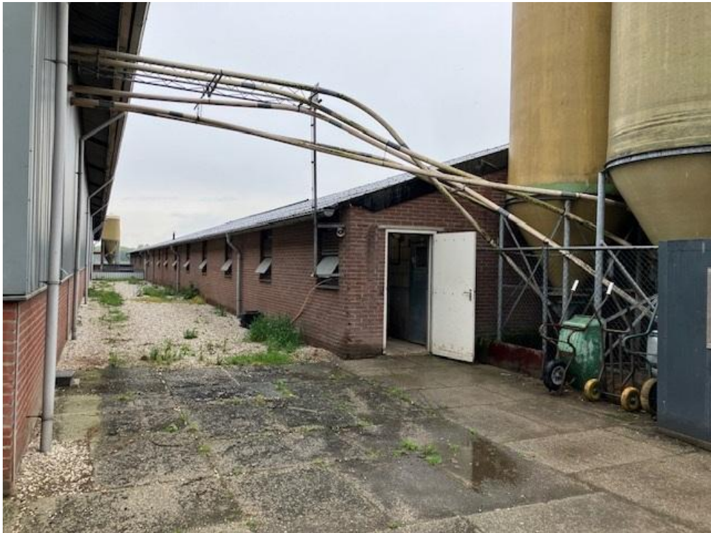
• Afbeelding 23: Te slopen stal
