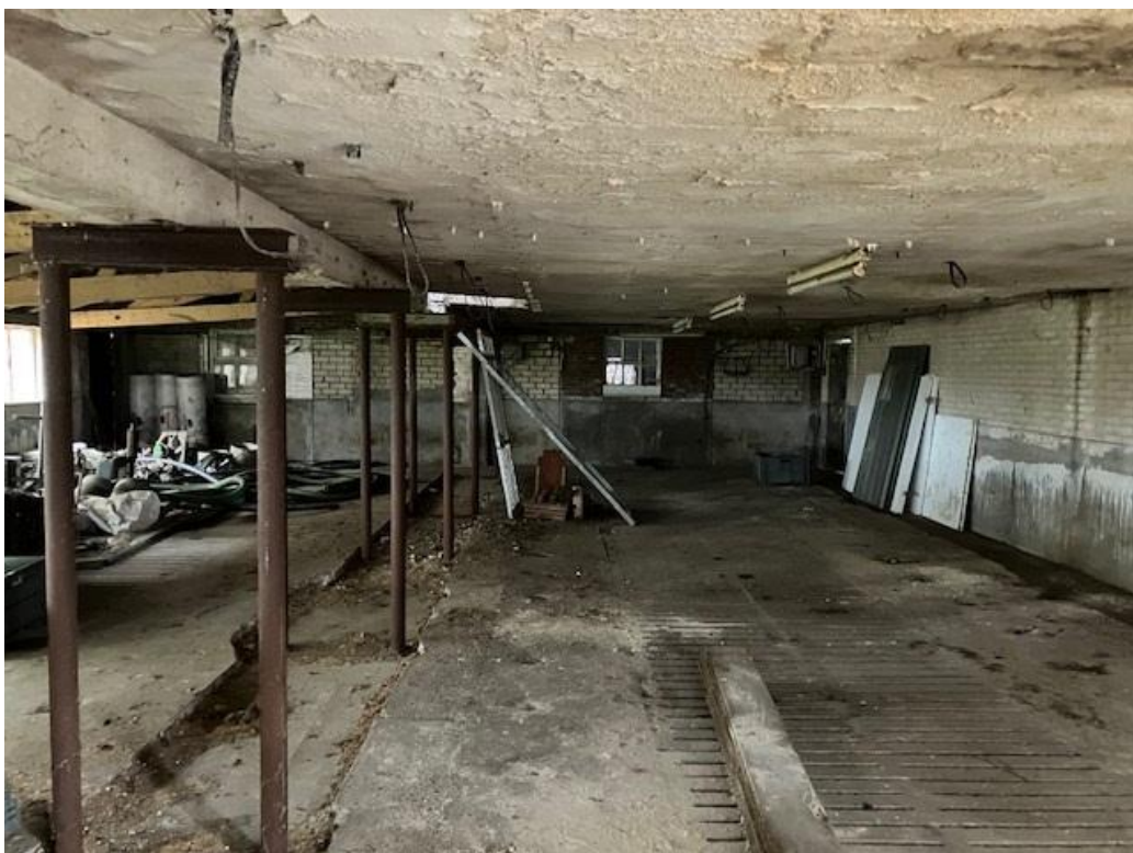
• Afbeelding 12: Binnenzijde achterhuis. Dit deel blijft behouden
