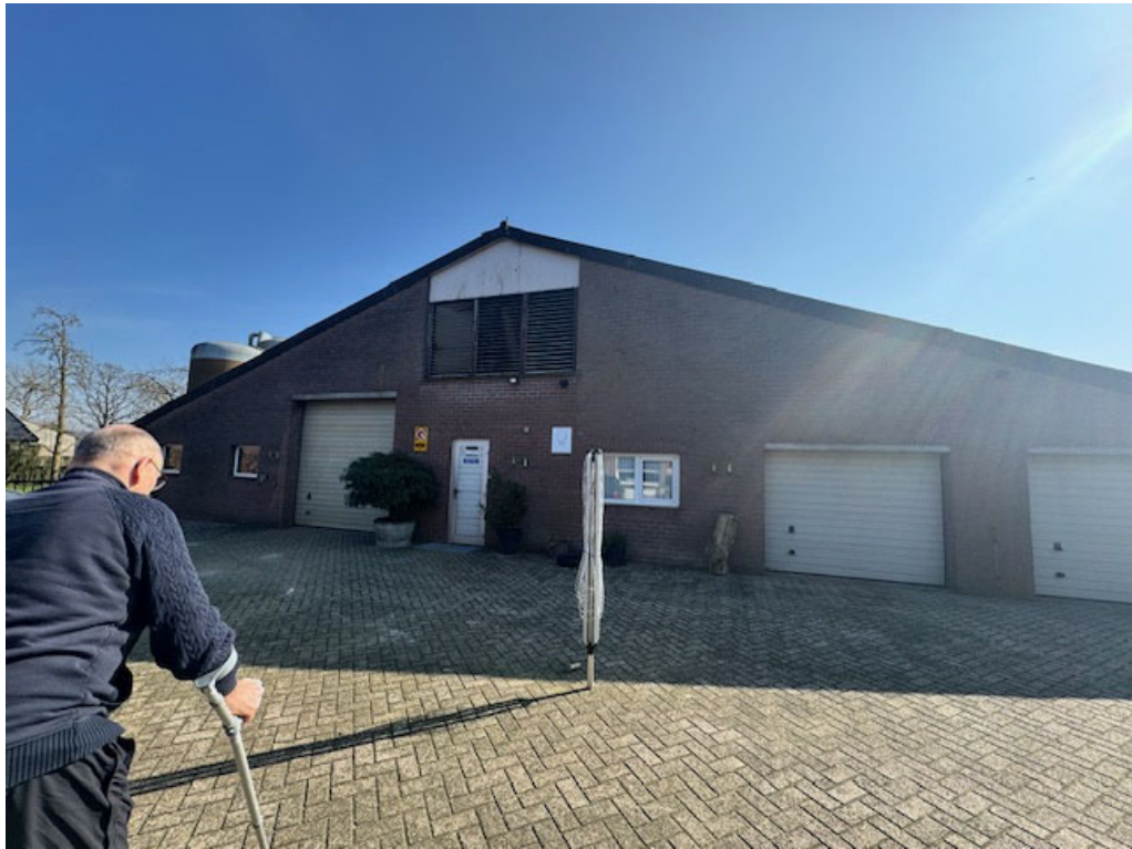
• Afbeelding 4: voorgevel te slopen stel
