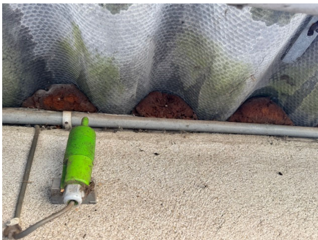
• Afbeelding 21: onderzijde dak dicht gepurd
