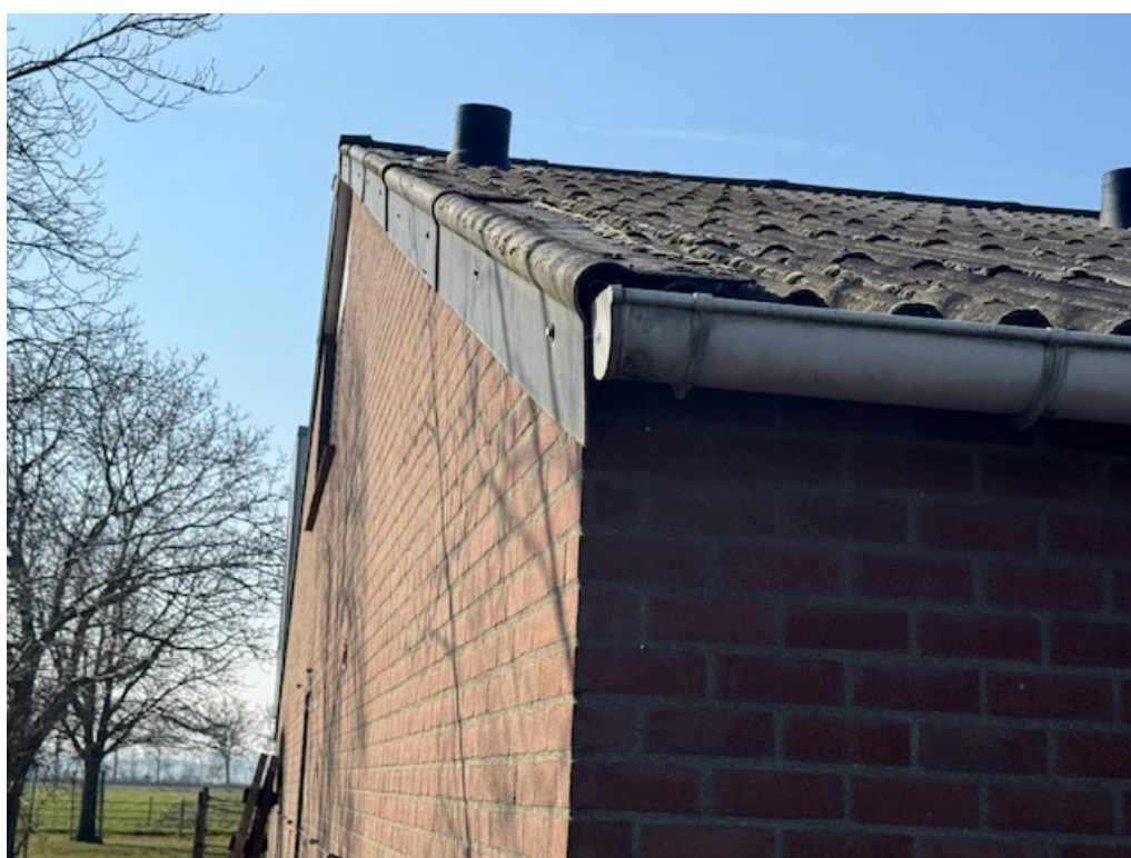
• Afbeelding 17: achtergevel te slopen stal
