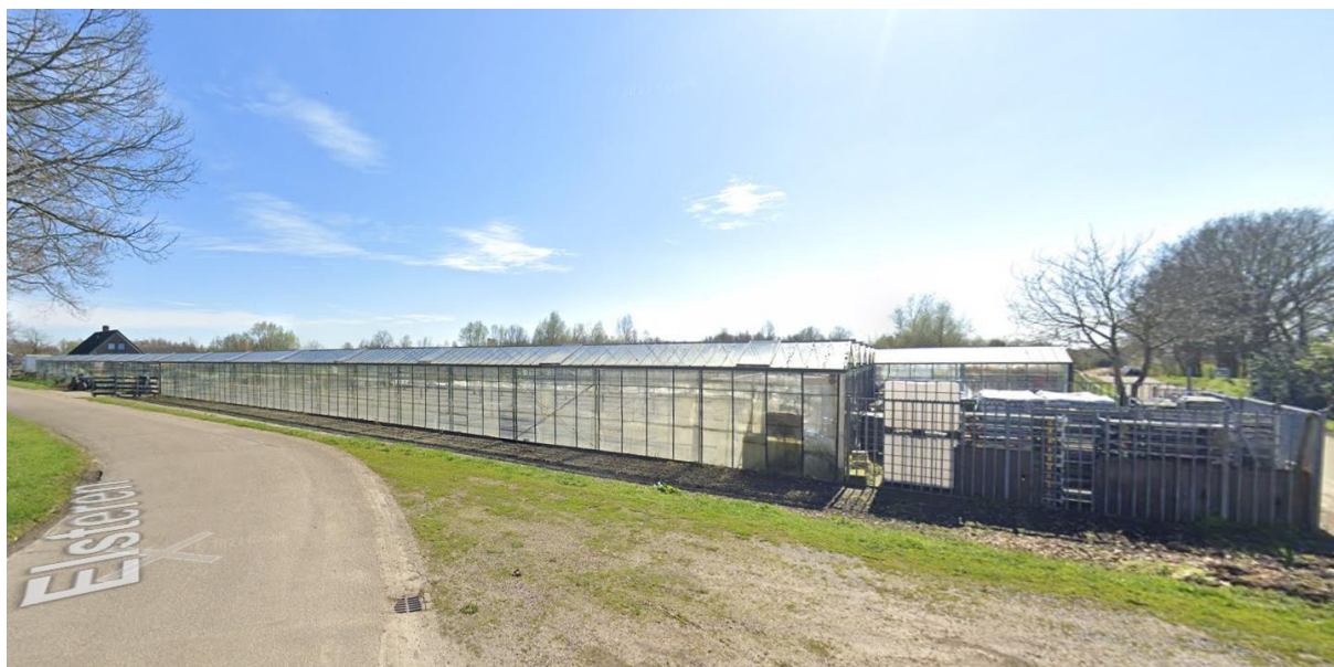
Figuur 3 Foto huidige situatie plangebied met kassen en bedrijfswoning (links)
