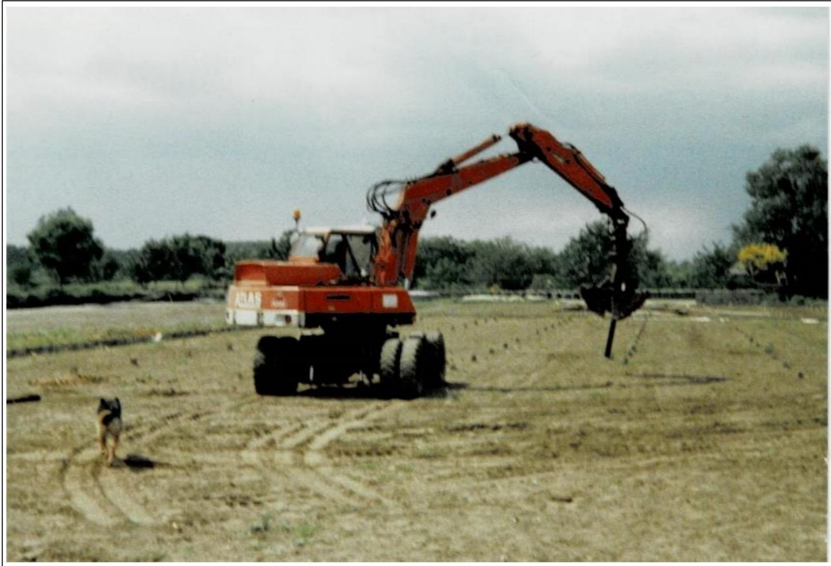
Figuur 10: foto van de bouwwerkzaamheden van de kas uit 1985 (bron: initiatiefnemer).
