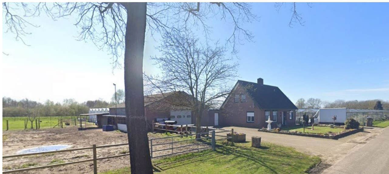
Beeld 1. Bestaande situatie bedrijfswoning
