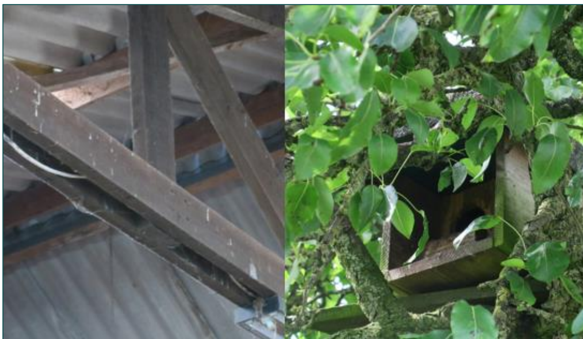
Figuur 3.2 Links In de te slopen/renoveren schuur zijn meerdere krijtsporen aanwezig, die duiden op aanwezigheid van de steenuil. Rechts: 10 m ten oosten van de planlocatie is een steenuil kast aanwezig in een perenboom.
