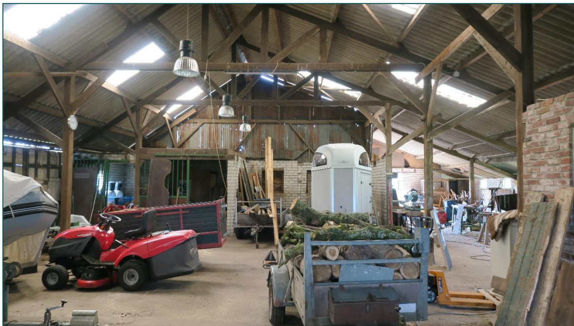
Figuur 2 De te slopen en renoveren schuur is opgebouwd uit gemetselde muren met een golfplaten (asbest) zadeldak, zonder dakbeschot.
