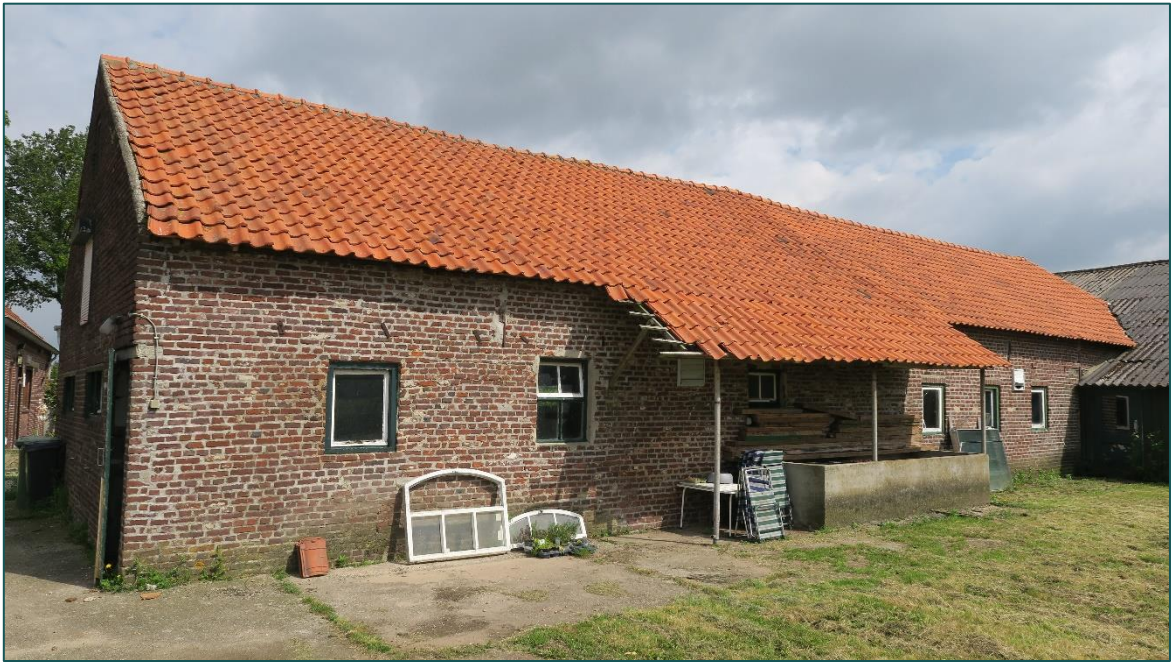
Figuur 3 De naastgelegen schuur is opgebouwd uit gemetselde muren met een dakpannen zadeldak. Deze schuur wordt niet aangetast in de beoogde ruimtelijke ingreep.
