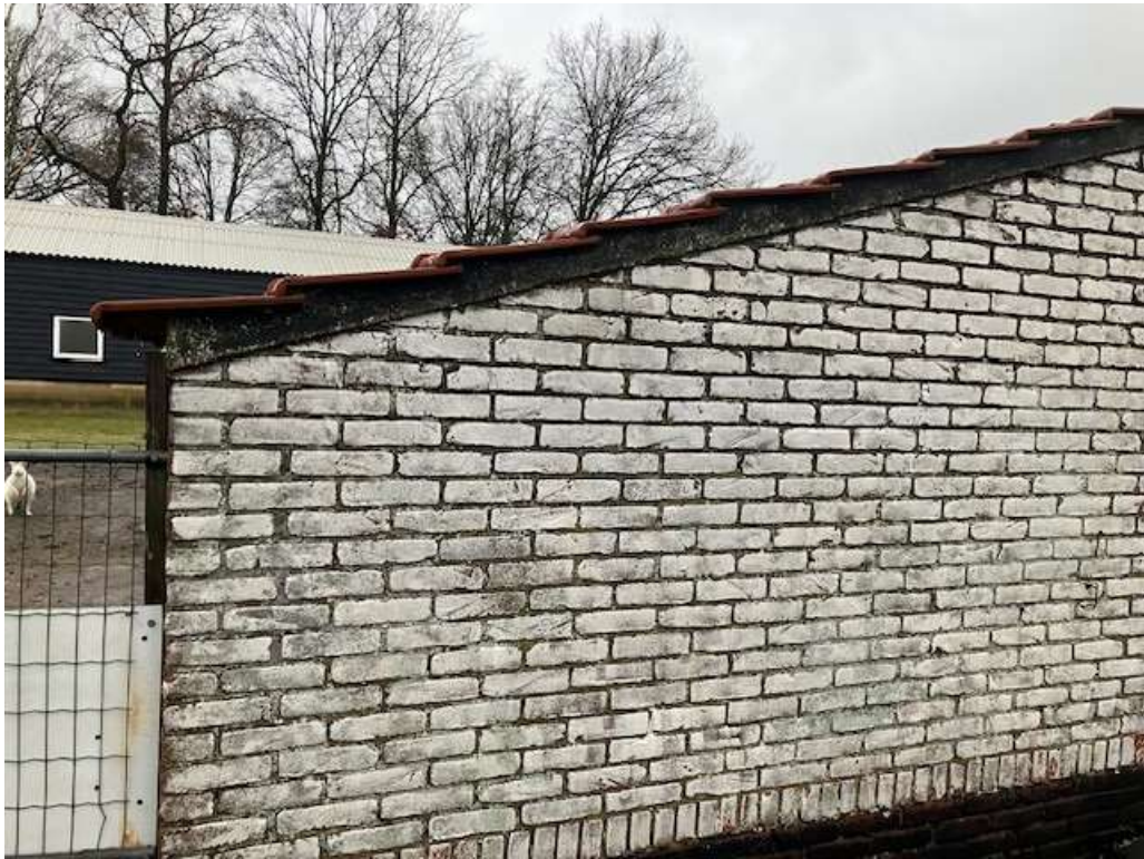
• Afbeelding 10: twee oude kippenhokken, worden gesloopt, slechte bouwkundige staat
