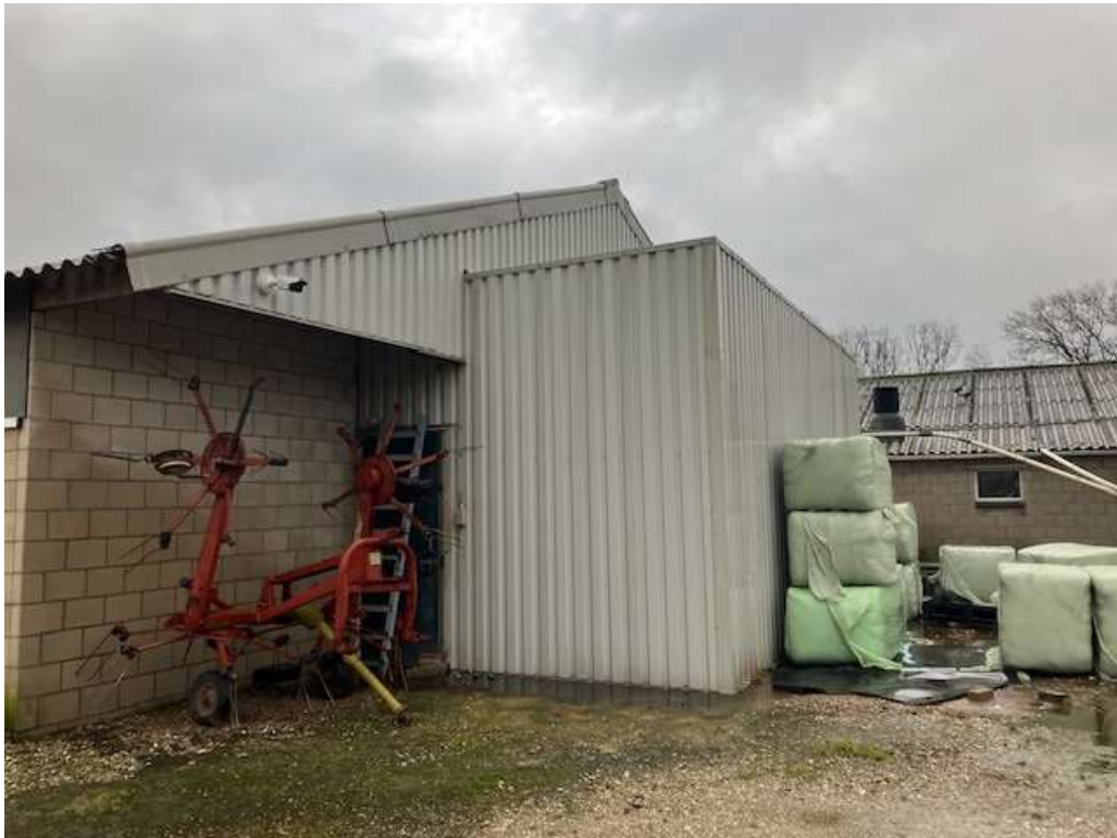
• Afbeelding 12: Achterzijde varkensstal met luchtwasser
