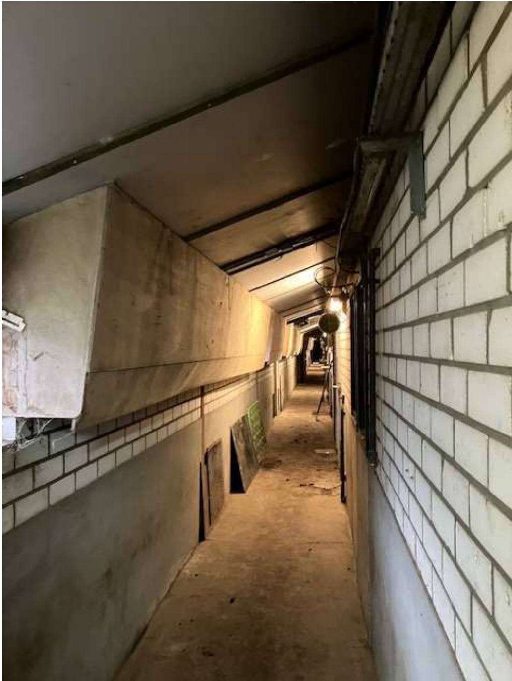
• Afbeelding 24: centrale gang in de stal
