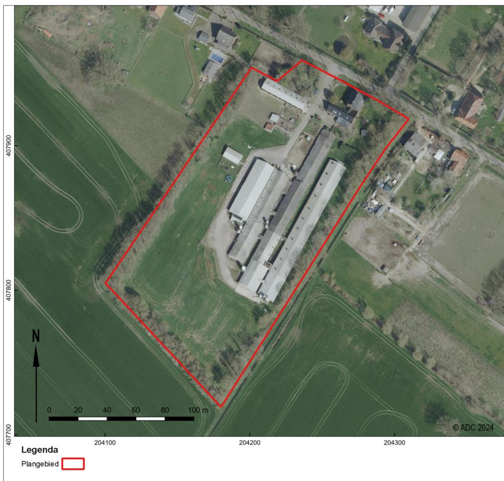
Afb. 2. Luchtfoto van het plangebied.
