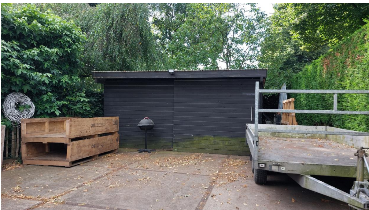
Figuur 4.5. De te verwijderen berging.
