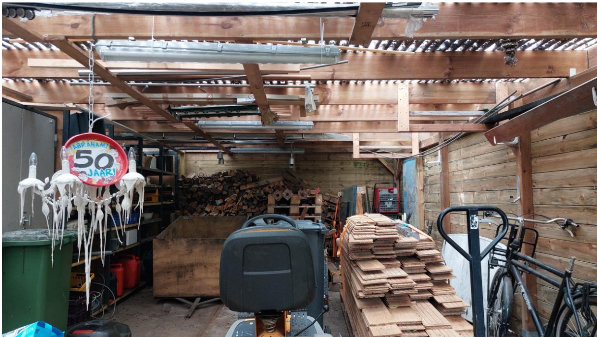
Figuur 4.2.1. De berging is geheel enkelwandig.
