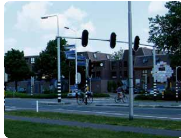
huidige verkeerssituatie Rijksweg bij gemeentehuis
