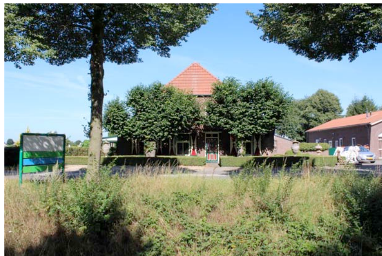
de Leilindes bij de kopgevel
