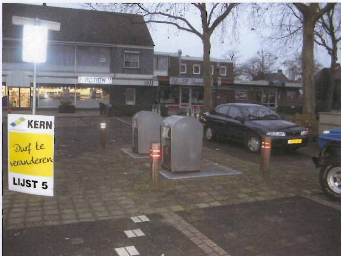
In de bodem geïntegreerde afvalcontainers
