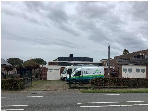
Foto 1 Westelijke oprit van de horecagelegenheid
