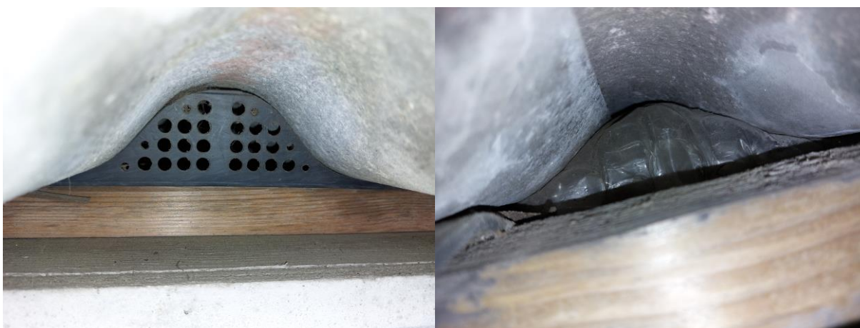
Figuur 4.2.5. Vogelschroot of folie voorkomt toegang voor vleermuizen en vogels.
