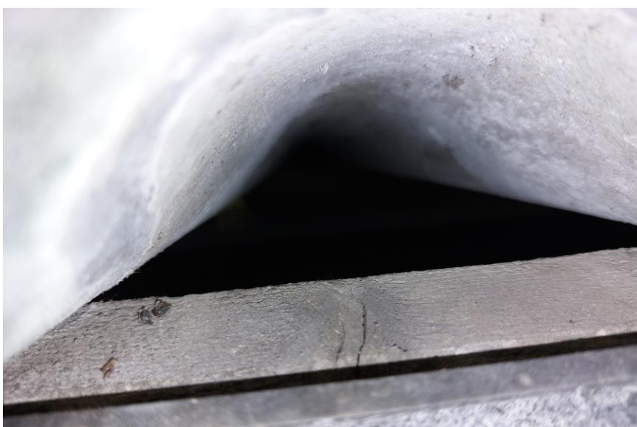
Figuur 4.2.9. Huismussen kunnen onder de golfplaten nestelen.
