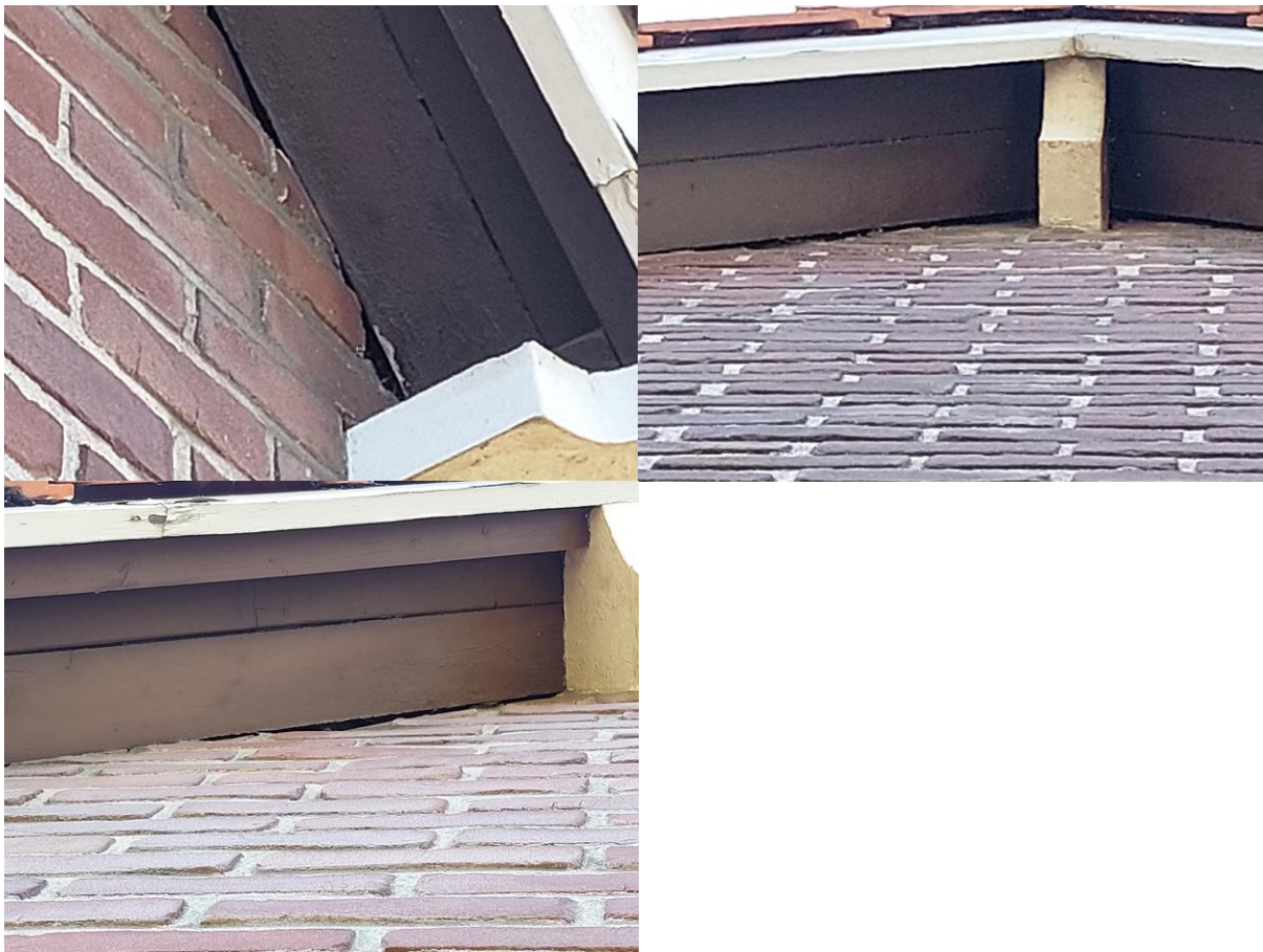
Figuur 4.2.2. Tussen het dakoverstek en de voorgevel bevinden zich spleten waardoor vleermuizen achter het hout of in de spouw kunnen verblijven.
