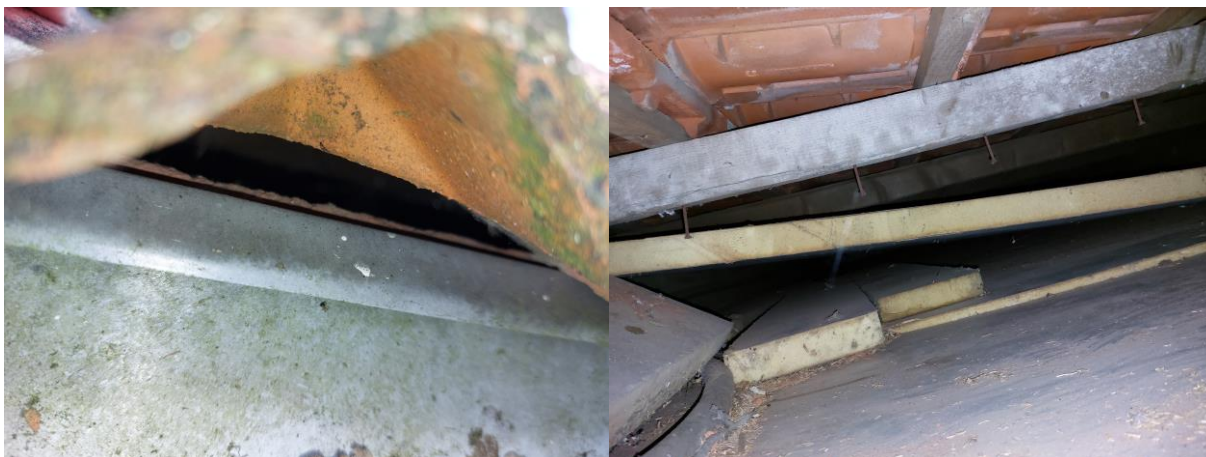
Figuur 4.2.8. De opening onder de dakpannen is voor vogels te nauw; voor vleermuizen is de ruimte onder de dakpannen te open en is het dakbeschot te glad.
