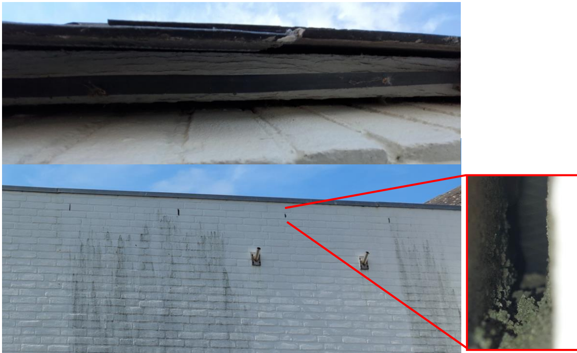
Figuur 4.2.6. Vleermuizen kunnen door de open stootvoegen (onder) en spleten onder de boeiboorden (boven) in de spouw of achter het boeiboord verblijven.
