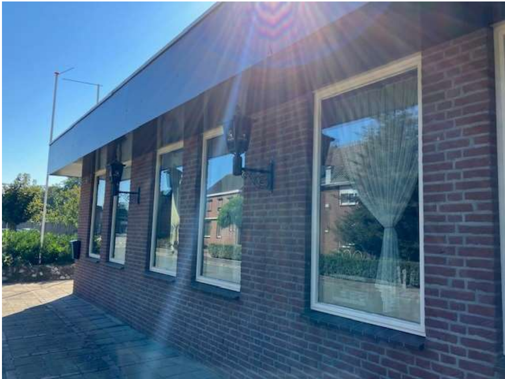
• Afbeelding 12: Voorgevel restaurant, boei gemaakt van Trespa
