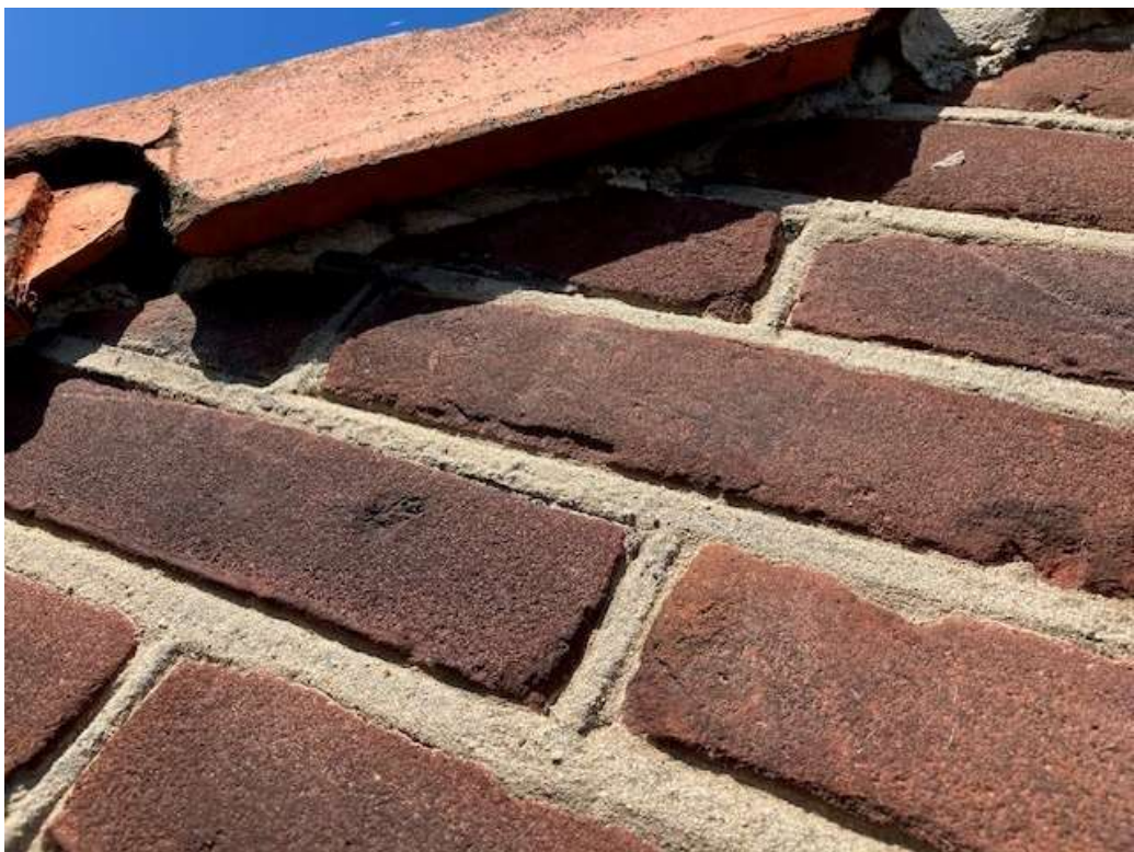
• Afbeelding 15: volgestorte kantpannen
