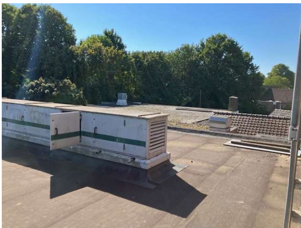
• Afbeelding 17: Plat dak restaurant, op de achtergrond het plat dak van de zaal
