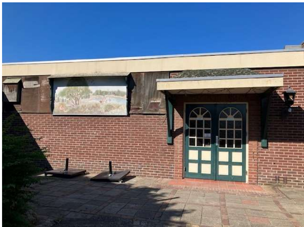
• Afbeelding 6: Voorzijde zaal wordt gesloopt
