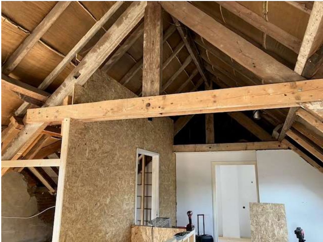
• Afbeelding 14: zolder woonhuis, wordt op dit moment verbouwd
