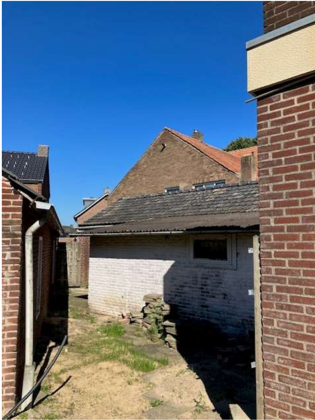
• Afbeelding 9: Achterzijde woonhuis
