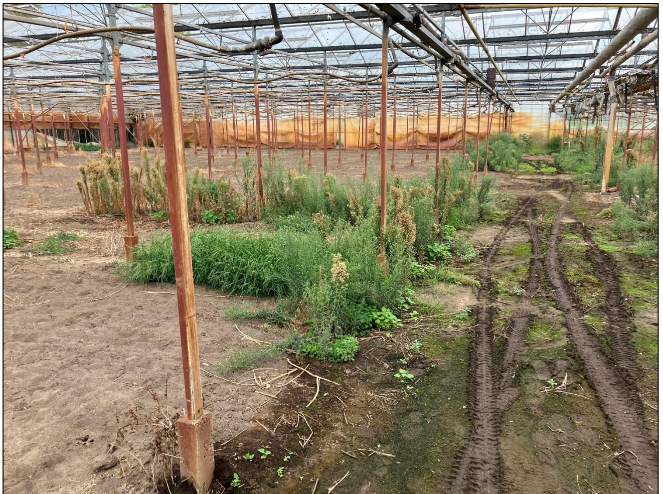
Figuur 5. Foto van het centrale deel van het plangebied, kijkende in noordelijke richting (Foto: 9 augustus 2023).
