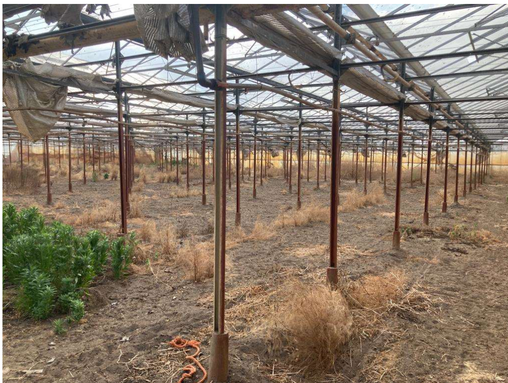
• Afbeelding 11: binnenzijde voormalig kassencomplex
