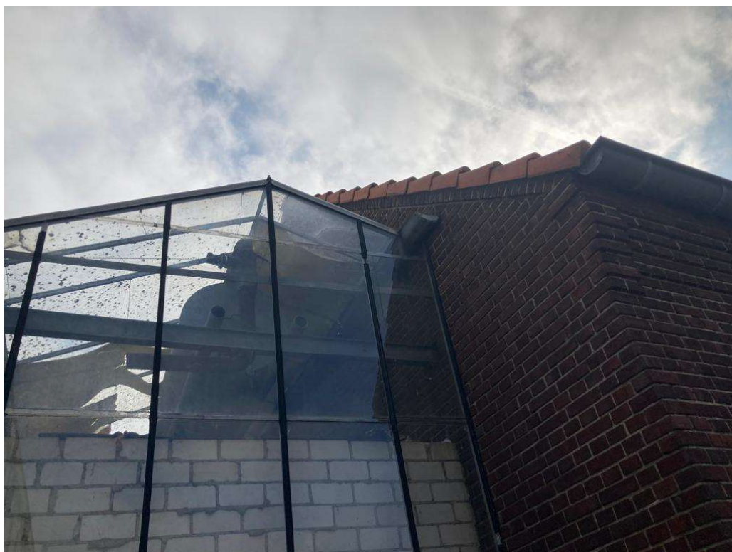
• Afbeelding 13: linker zijgevel aangebouwde schuur met kassencomplex
