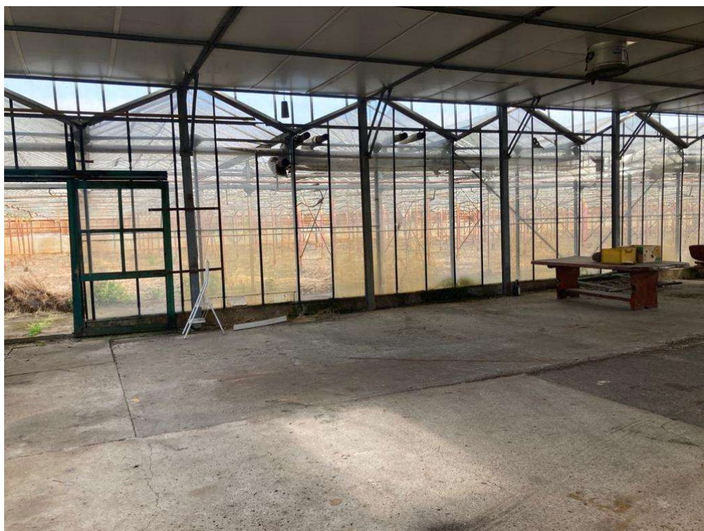
• Afbeelding 14: binnenzijde voormalig kassencomplex
