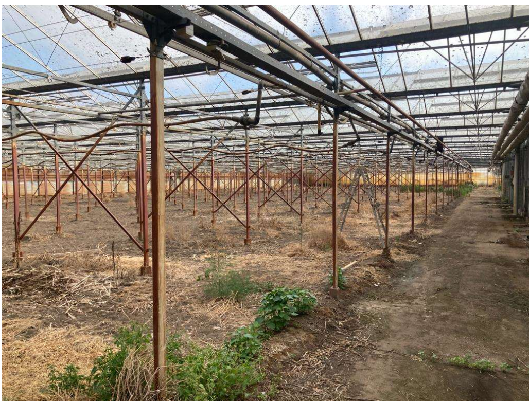
• Afbeelding 12: binnenzijde voormalig kassencomplex
