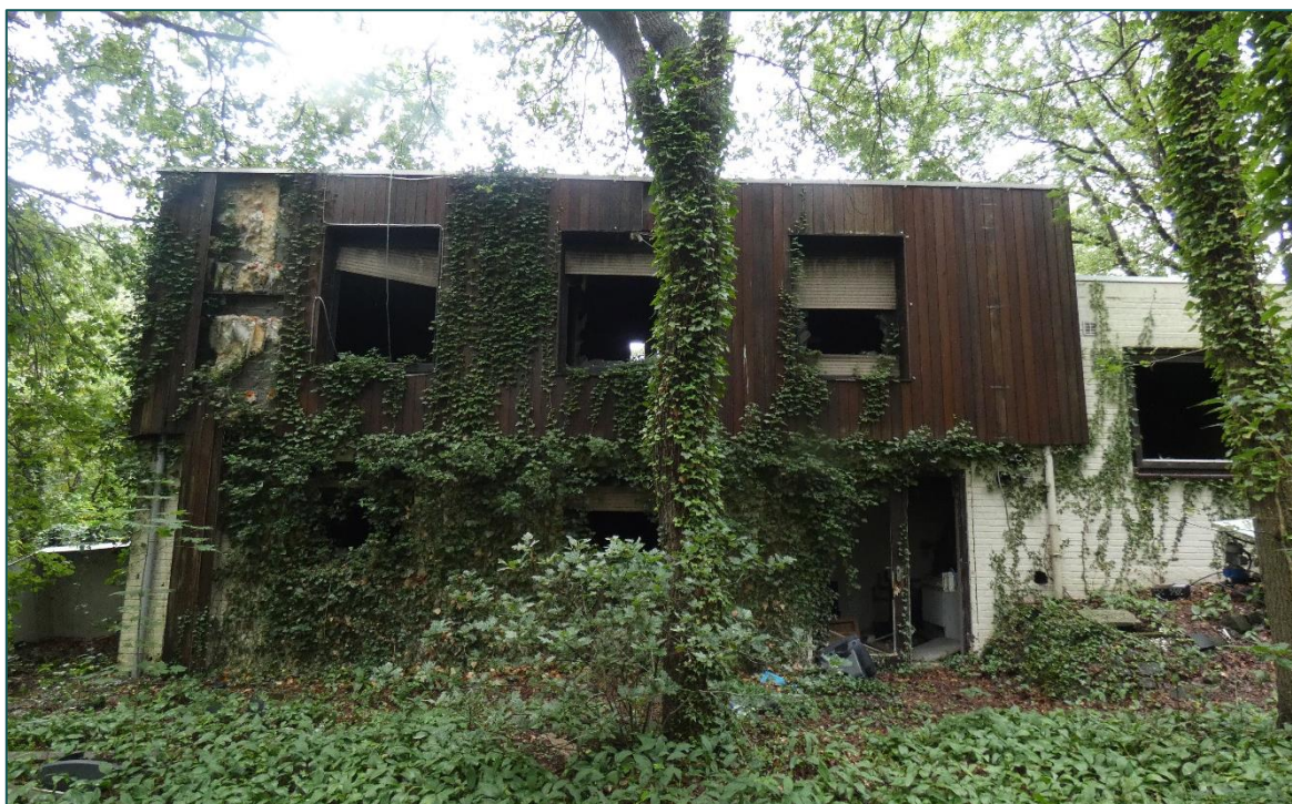
Figuur 1 De planlocatie is gelegen aan Moleneind 2a te Well (L) en bestaat uit een bebost gebied met in het midden gelegen bebouwing.
