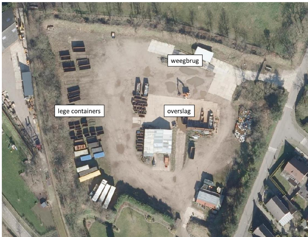
Figuur 3-1 Overzicht terrein Xhofleer Recycling
