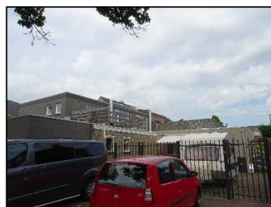
Figuur 8. Achterzijde onderzoekslocatie vanaf het zuiden gezien.
