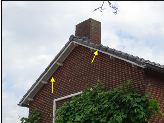
Figuur 15. Geschikte verblijfplaatsen voor vleermuizen in de woning aan de Keulerstraat 3.
