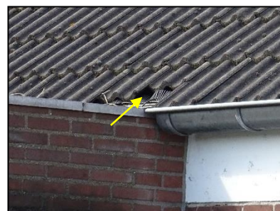
Figuur 11. Ruimte onder dakpannen geschikt als broedplaats huismus en gierzwaluw.
