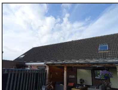
Figuur 6. Dakterras achterzijde onderzoekslocatie.
