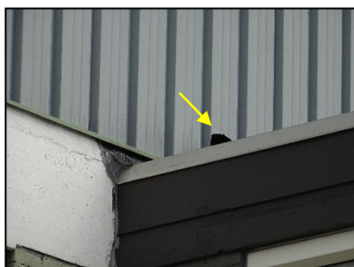
Figuur 10. Gat in gevel geschikt als broedplaats gierzwaluw.
