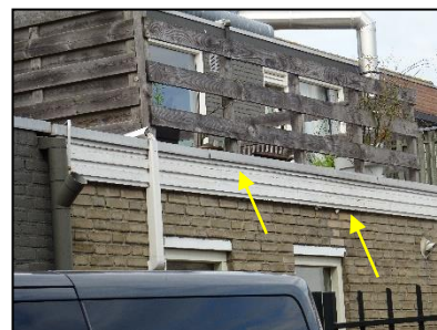
Figuur 14. Ruimte achter betimmeringen en daktrim geschikt voor vleermuizen.
