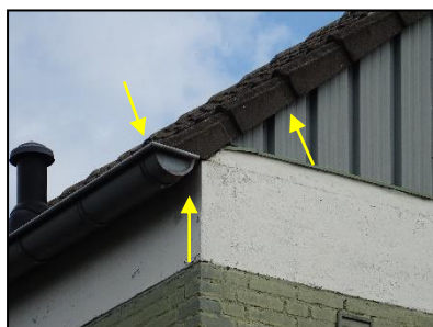
Figuur 9. Ruimte onder dakgoot en dakpannen geschikt als broedplaats huismus en gierzwaluw.
